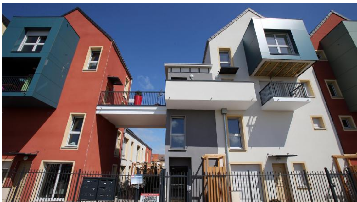
Formes urbaines intermédiaires au sein de l'Ecoquartier Descartes à Calais. Crédit photographique : La Voix du Nord.
