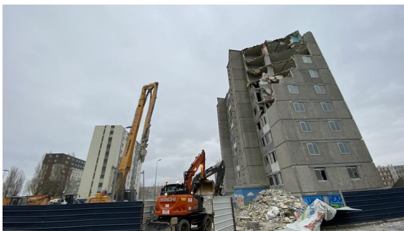
Démolition de la tour rue d'Ajaccio au sein du Quartier Prioritaire de la Politique de la ville du Fort Nieulay, à Calais en janvier 2024. Un exemple de démolition qui engendre des besoins en renouvellement positifs. Source et crédit photographique : La Voix du Nord
