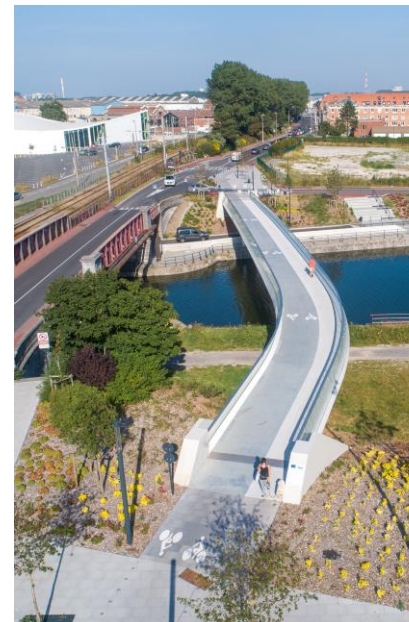
Passerelle cyclo-piétonne en parallèle du pont Mollien :
